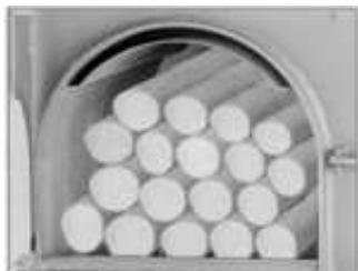
Charger le bois quand il y a un lit de braise. Ouvrir doucement la porte du magasin bois pour permettre au ventilateur d'aspirer les fumées qui se sont formées dans le magasin bois. En utilisant le pique-feu, ranger la braise sur la pierre principale d'une manière uniforme. Ensuite, on pourra charger du bois en petits morceaux de la même longueur du foyer.
