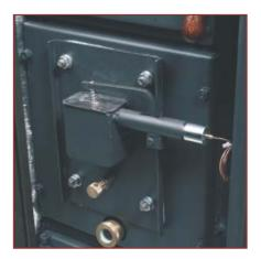
Il modulatore è quasi completamente chiuso, la caldaia funziona alla potenza minima, in seguito alla diminuzione della portata d'aria comburente connessa con la riduzione al minimo del passaggio d'aria.
