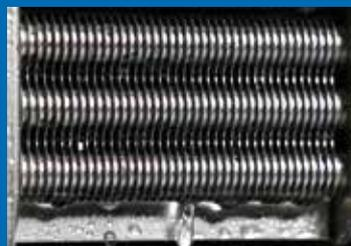
Scambiatore inox in fase di condensazione
